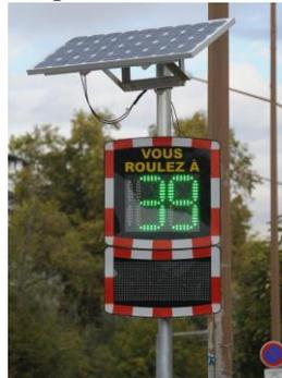
Le **radar pédagogique mobile** (avec enregistrement des données) vient d'être installé pour sensibiliser les automobilistes au respect de la vitesse sur la commune. Des baisses de régime ont d'ores et déjà été constatées...
